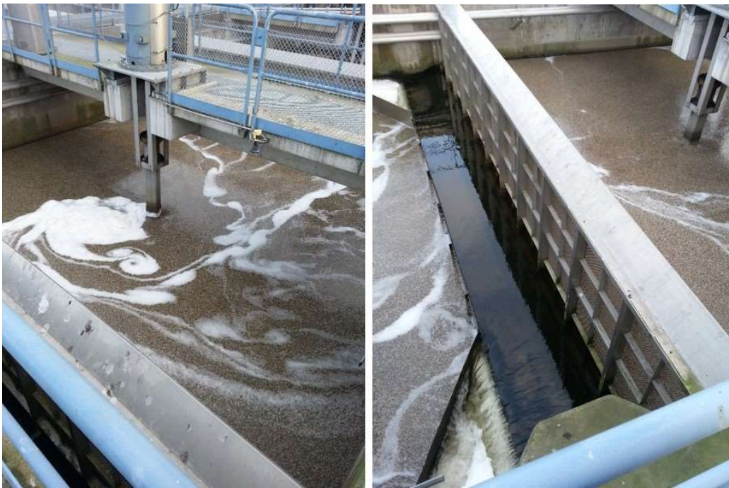
Figur 12-4. Suspenderade biofilmbärare (MBBR). Bilden till höger visar gallret som separerar bärarna från det renade vattnet.
